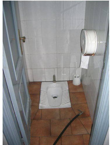
Arreglo de baños de estampación.
